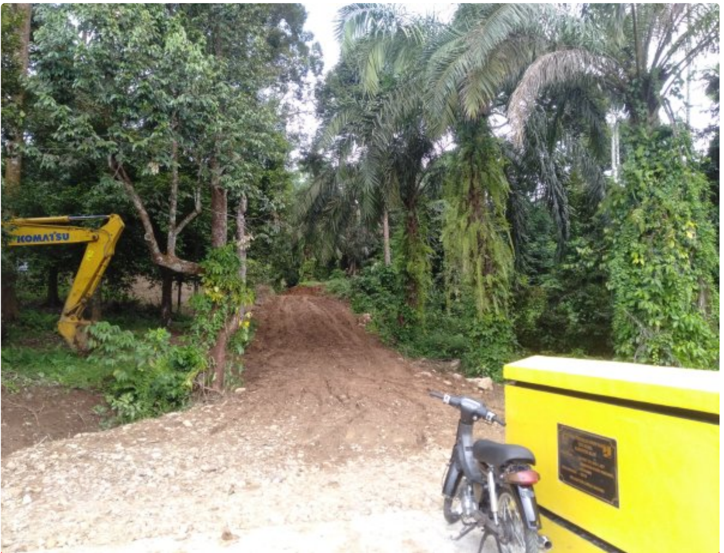
Jalan baru Banda Talang ke Buluah Kasok belum diaspal
